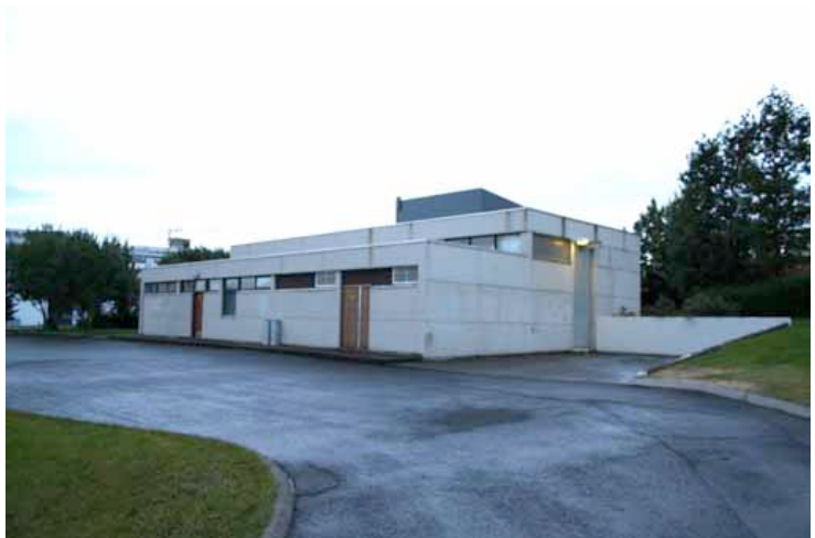
15. mynd. Dælustöð í Reykjavík, Bolhóltsstöð. (Ljós. Sveinn Þórðarson).
