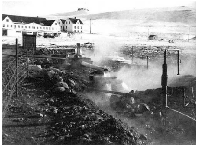
6. mynd. Borhola á Suðurreykjum í Mosfellssveit. Bæjarhúsin í baksýn voru hituð með hveravatni 1908, fyrst allra húsa á Íslandi.
