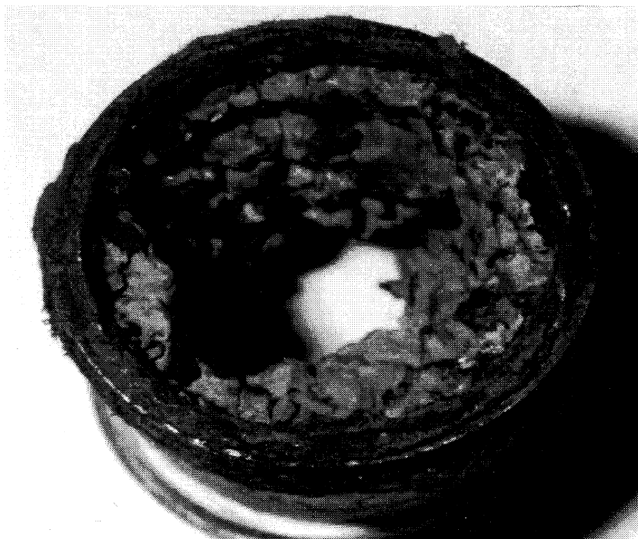
Mynd 6.8.1 Tæringarmyndanir í galvanhúðuðu röri. Þær eru að loka rörinu, þar sem það tengist ryðfríu tengistykki.
